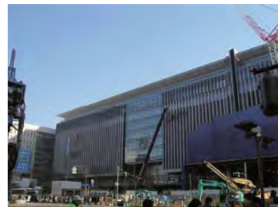
九州新幹線開通に向けて、新築・改装に活気づく「博多駅」。複数の重機が並んでいます。
